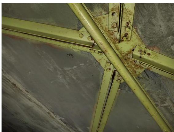
Obr. 7: Nekvalitní provedení přípoje ztužidel - chybějící šrouby
