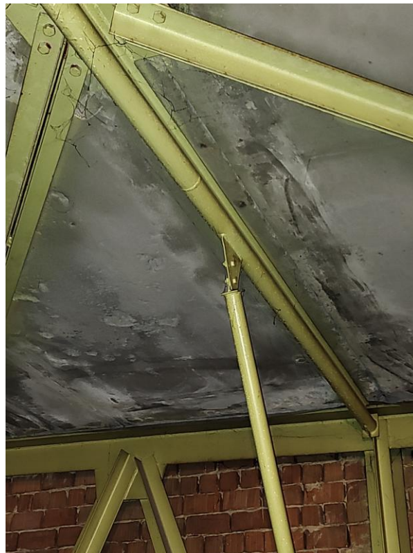
Obr. 9: Nedostatečná tloušťka styčnickového plechu pro připoj ztužidla
