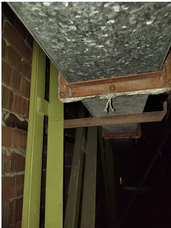
Obr. 8: Nevhodné kotvení konzoly na svislici vazníku
