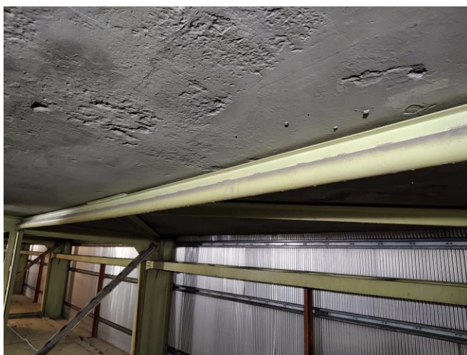
Obr. 2: Nadměrný průhyb střešního panelu, podepření ztužidlem
