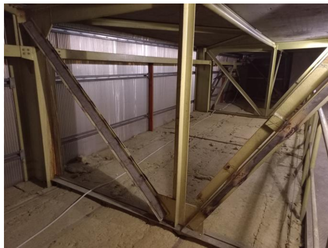
Obr. 3: Původní „zesílení“ diagonál
