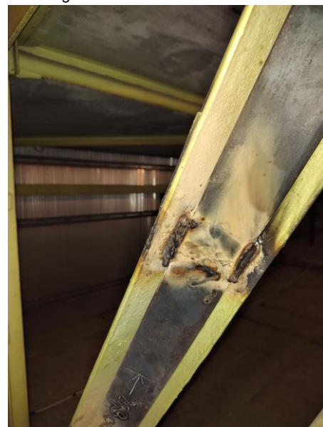
Obr. 5: Detail původního "zesílení" diagonál
