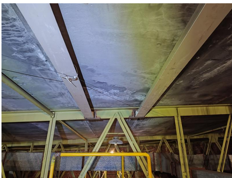
Obr. 4: Dodatečná konstrukce pro podchycení střešních panelů
