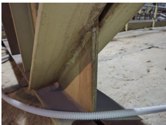
Obr. 6: Nekvalitní provedení svaru
